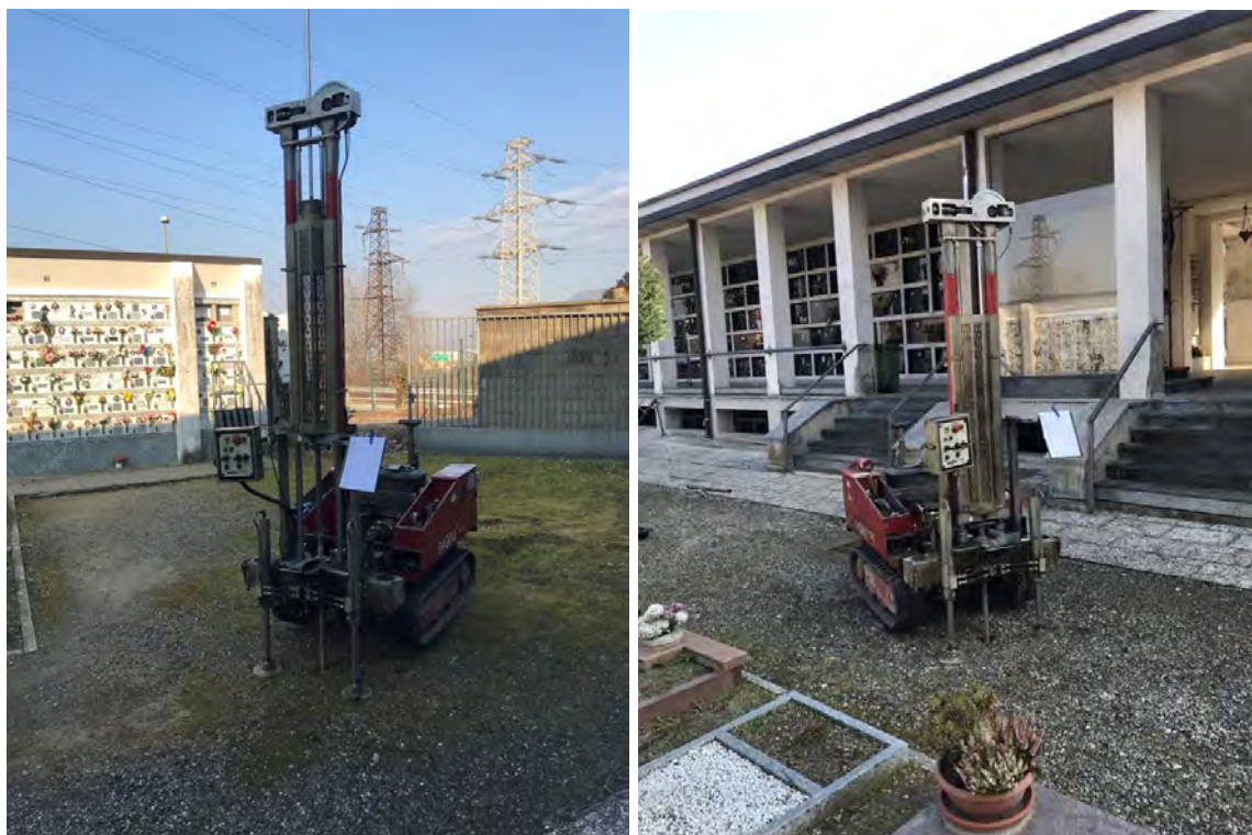
Esecuzione delle prove penetrometriche.
