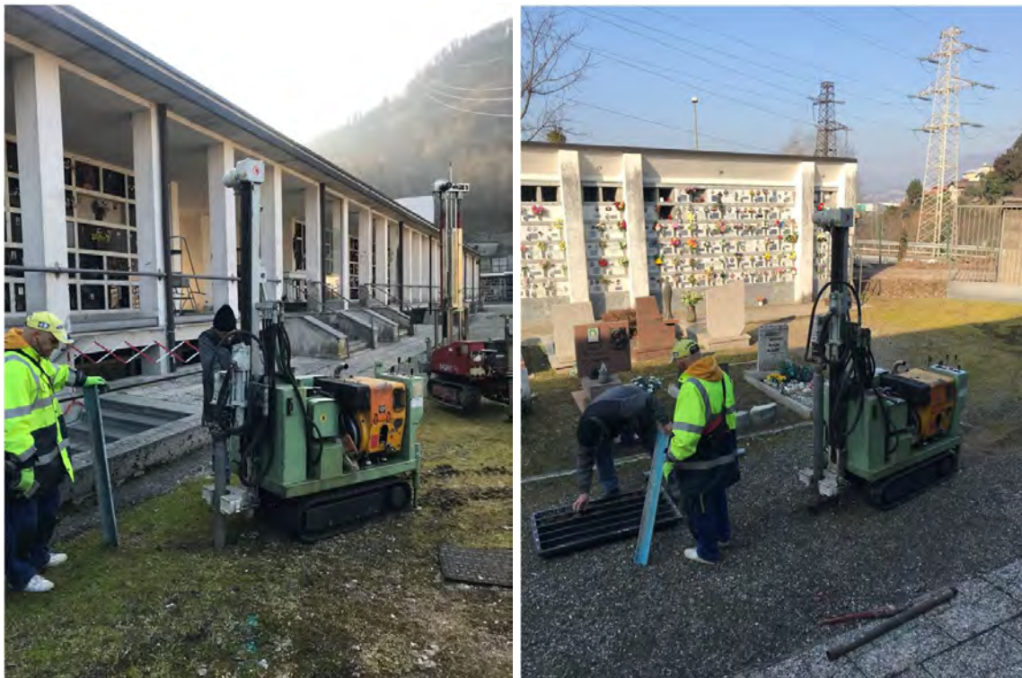
Esecuzione dei sondaggi.
